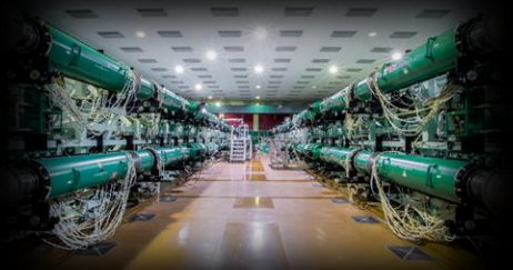
激光12号レーザー施設
